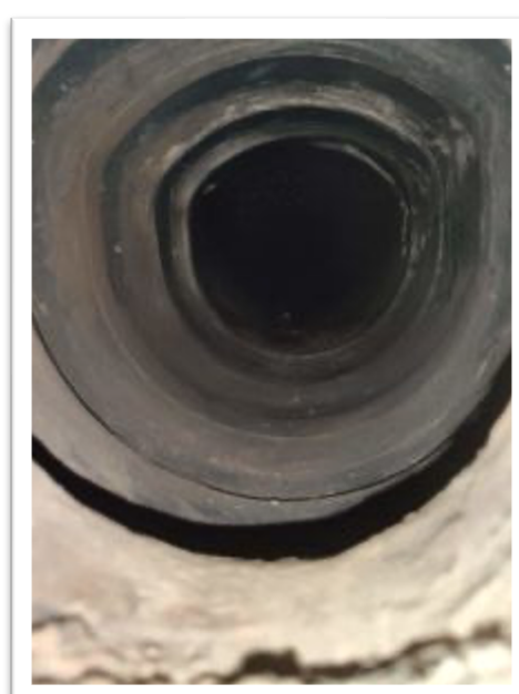
Chambre de combustion nettoyée
