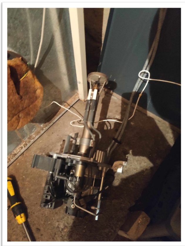
Démontage et nettoyage du brûleur fuel
